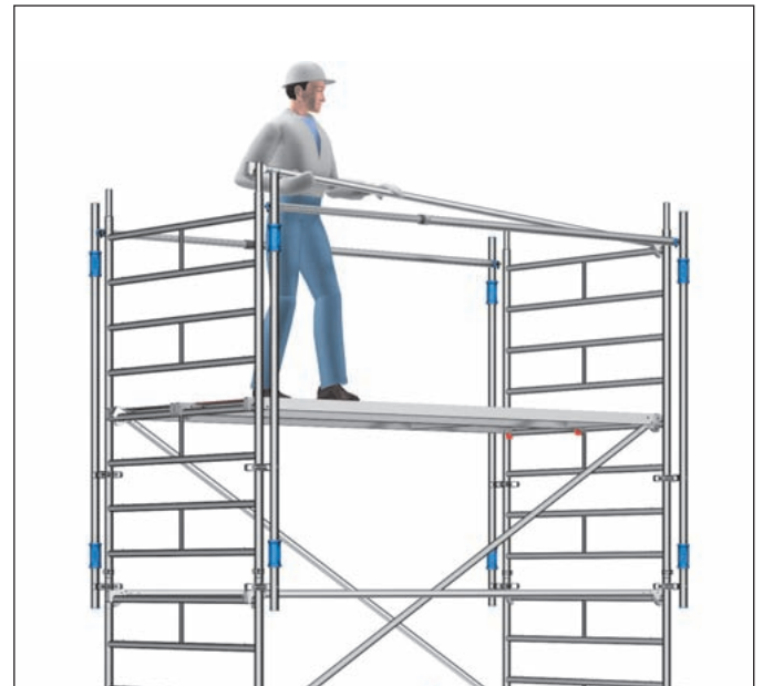
Bild 6: Sichere Montage der Rückenlehnen mit MSG
